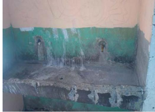
Módulo C2 pilas para lavado de ropa totalmente inservibles
