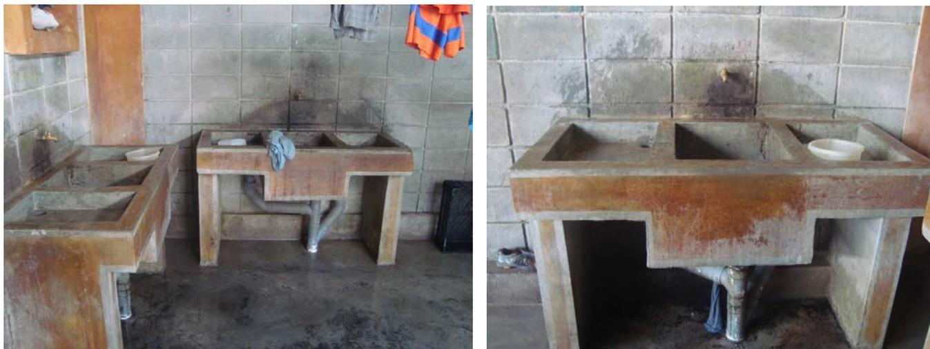
Pilas en mal estado con fugas, que generan acumulación de agua en el piso
