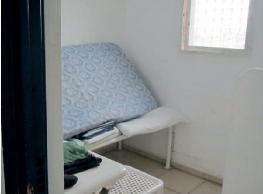
Habitación de separación de grupo en "Sograndio" (Asturias)
