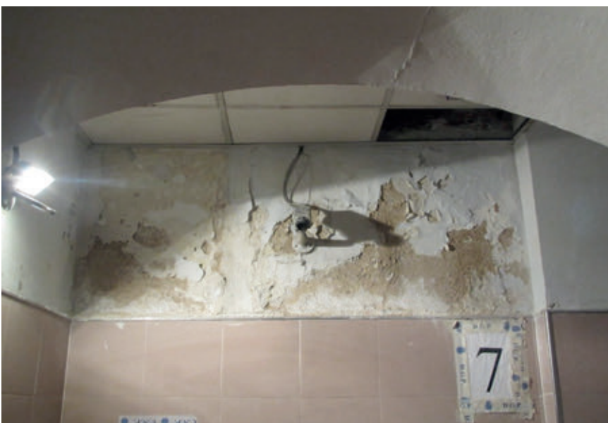
Zona de calabozos en la comisaría del CNP del Distrito Centro de Madrid
