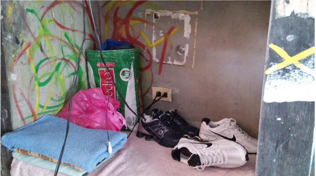
Imagen tomada en la sección D1, donde se aprecia la presencia de ropa y material inflamable cerca de las tomas de electricidad
